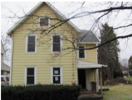
59 W Main St., Owego, NY 13827
