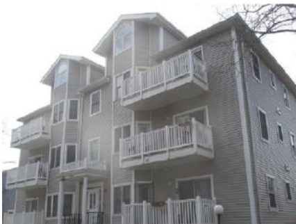
4501 Bergenwood Ave 1-1c, North Bergen, NJ 07047
