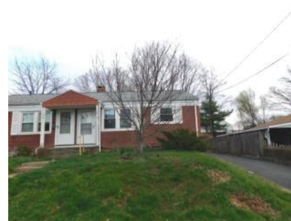
188 Buena Vista Ave, Newington, CT 06111
